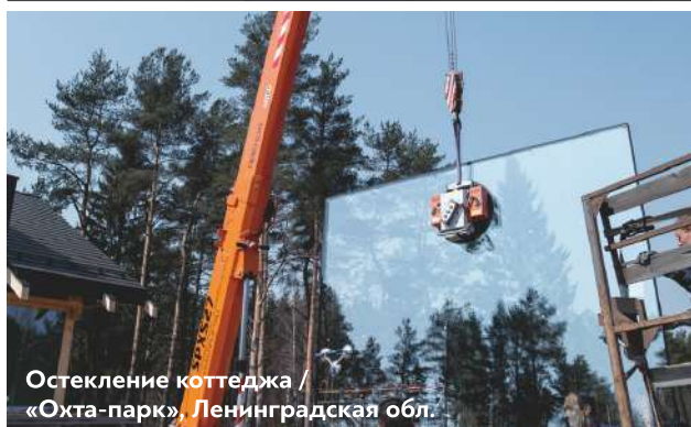
Монтаж крупногабаритного стекла
